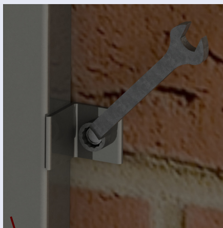
Figura 12 - Apertar Parafuso
