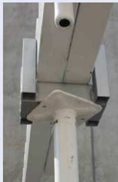
Sobreposição de Porta-Vigas com encaixe em "U"
